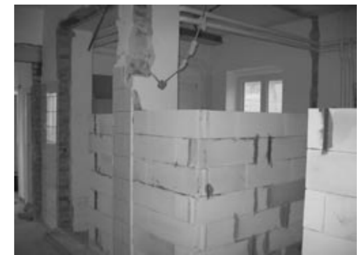
Az óvodában minden nyílászáró megbontásra került
