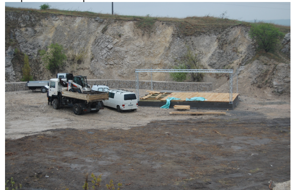
Az eső is hátráltatja a munkákat a színpad építésénél.
